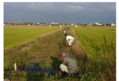
(水路更新のための測量作業)
